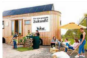
Das Tiny House „Ferdinand“ hat eine eigene Solaranlage. FOTO: KLIMAWOCH
