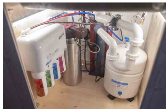
Die moderne Wasseraufbereitung im Tiny House – und im Boden ist ein 300-Liter-Frischwassertank. © Röer
